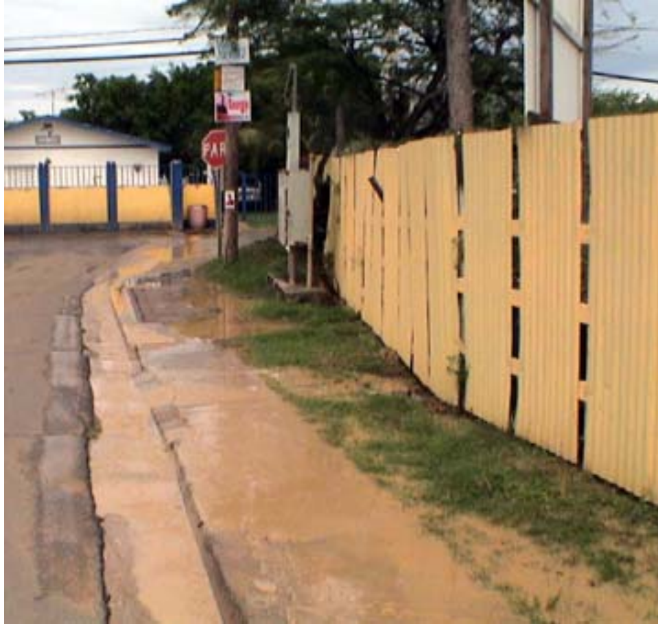
FIGURA 83. Escorrentías ilegales proveniente de proyectos de construcción. El drenaje de aguas bajo el nivel freático en proyectos desarrollados muy cerca del nivel del mar también causan continuamente una descarga mensual de toneladas de sedimentos finos hacia la bahía de Ensenada Honda. Muchos de los proyectos desarrollados en Culebra carecen de las medidas requeridas por leyes estatales y federales para la descarga de aguas de escorrentías y de contaminantes. Tampoco dichos proeyctos poseen mecanismos adecuados y requeridos por ley para el control de la erosión y la sedimentación, afectando directamente la costa mediante la descarga de escorrentías altamente sedimentadas y cargadas de nutrientes a través del sistema de cunetas para el drenaje pluvial.
