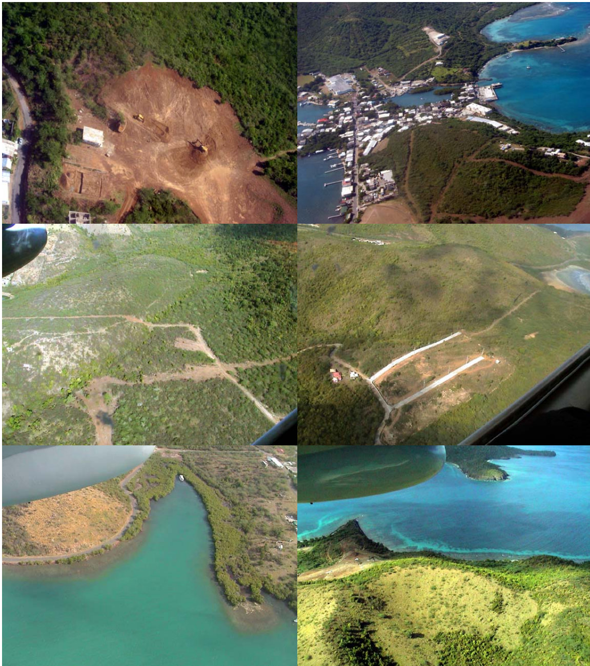
FIGURA 13. Otros ejemplos de las prácticas pobres en el manejo del uso de los terrenos en Culebra: A) deforestación masiva para la construcción de viviendas, proyecto que nunca se llevó a cabo; B) y C) ejemplos de caminos sin pavimentar en pendientes muy inclinadas, sujetos a erosión severa y causando fragmentación de habitáculos naturales; D) deforestación y desarrollo ilegal en Monte Resaca detenido por el Tribunal Superior de PR; E) deforestación de terrenos inclinados frente a la costa causando un aumento dramático en la turbidez del agua; F) los fuegos intencionales frecuentes pueden causar la pérdida de cobertura vegetal, exponiendo pendientes inclinadas a la erosión.
